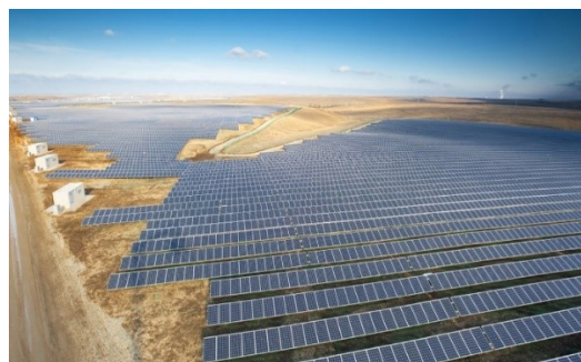
Рисунок 1 – Солнечная электростанция «Перово», республика Крым общая мощность 105,56 МВт, площадь 2 00 га
