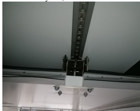
Рисунок 2 – Направляющий рельс подъёмно-сдвижных перегородок
