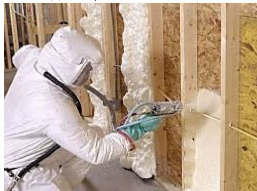
Рисунок 6 – Нанесение пенополиуретана
