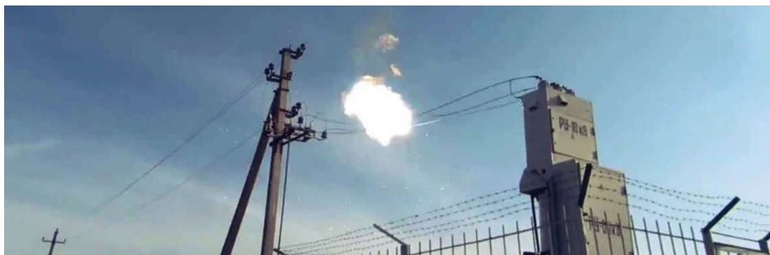
Рисунок 1 – Трёхфазное K^{(3)} короткое замыкание ЛЭП в непосредственной близости от трансформаторной подстанции (tmr-power.com)
