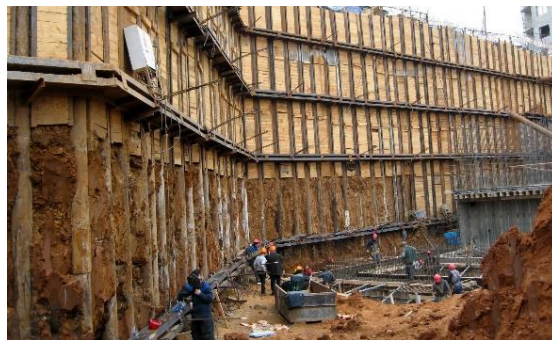
а - технология цементации; б - шпунтовое ограждение глубоких котлованов.
