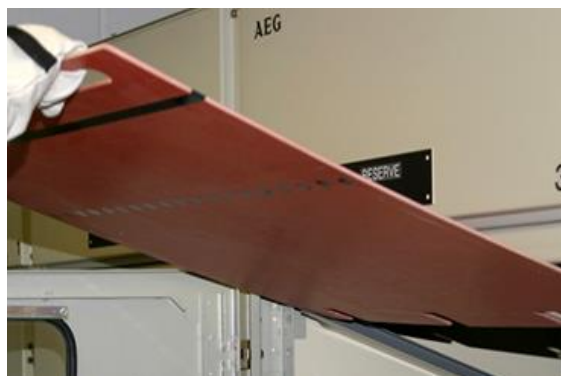
Рисунок 11 – Накладки изолирующие
