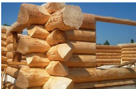
Рисунок 1.1 – Канадская рубка Рисунок 1.2 – Русская рубка Рисунок 1.3 – Норвежская рубка
