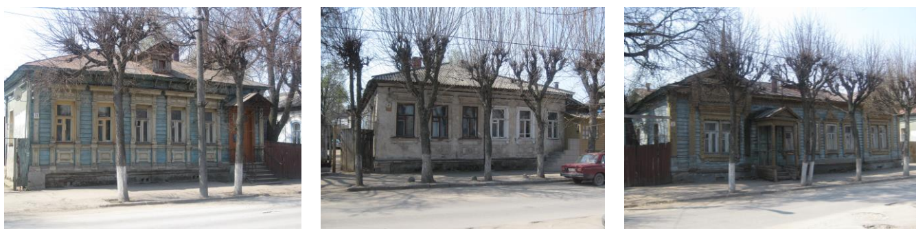
Рисунок 1.4 – Малоэтажная застройка, ул. Щедрина в г. Рязани
