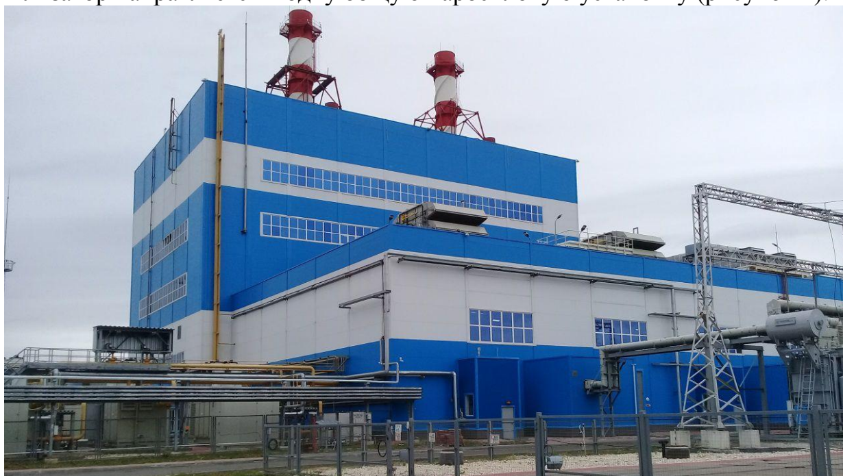
Рисунок 1 – Парогазовая установка 115 МВт Дягилевской ТЭЦ
